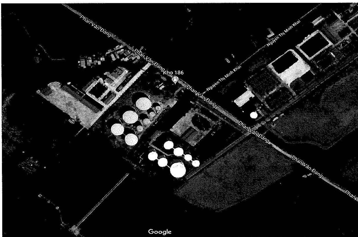
Cụm kho cảng 186/Cục Xăng dầu/TCHC do PEC thiết kế (Quy mô: 100.000m 3 và các hạng mục công nghệ; cấp thoát nước, an toàn cháy nổ, điện tự động hóa, v.v.)
